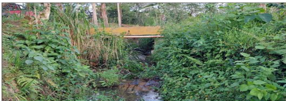
FIGURA N°02: TRAMODE LA QUEBRADA DONDE SE APRECIA LA COLMATACION POR SEDIMENTOS Y CON BORDOS A FALTA DE MANTENIMIENTO.
